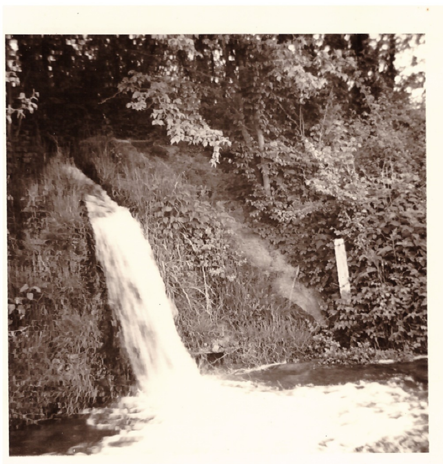
La chute qui alimentait le moulin. C'est une chute "artificielle". Un canal en maçonnerie a été aménagé dans un petit bosquet, afin d'obtenir la dénivellation suffisante.
